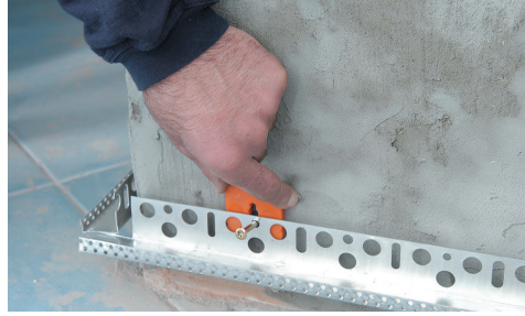
Subasman profilleri köşelerde açılı şekilde kesilir. (Resim 2)
