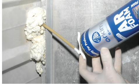
Levhalar arasında mümkün olduğunca boşluk bırakılmamalıdır. İnce boşluklar ısı yalıtım bandı veya köpük ( Arkim Arfoam ) kullanılarak doldurulmalı, 4 mm'den daha büyük aralıklar mutlaka aynı tip ısı yalıtım malzemesi kullanılarak kapatılmalıdır. Isı yalıtım levhalarının aralarına yapıştırma harcı dolmamasına özellikle dikkat edilmelidir. (Resim 4)
