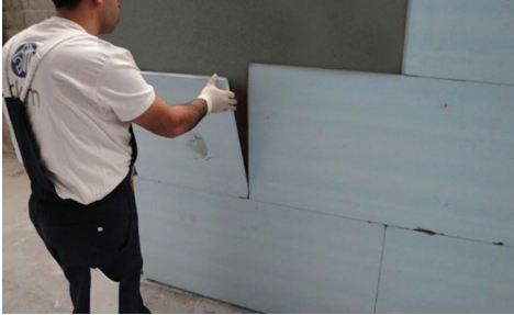
Isı yalıtım levhaları duvarın alt kısmından başlanarak yukarı doğru aralıksız ve şaşırtmalı olarak döşenir. Levhaların düzgün döşenmesine ve kenarların zedelenmemesine dikkat edilmelidir. Hasarlı ve özellikle kenarları aşınmış levhalar kullanılmamalıdır. Arkim Artherm AD veya Arkim Artherm Ready yapıştırma harçları kullanılarak levhalar döşenir. (Resim 3)
